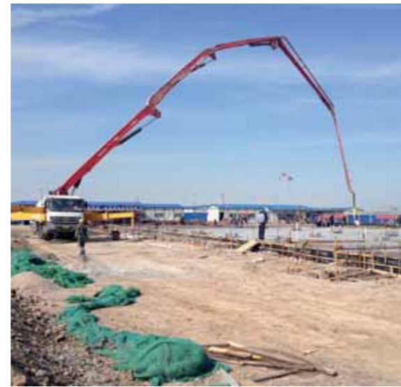
Der støbes fundament til de næste 6000 kvadratmeter fabriksareal – større end en fodboldbane.
